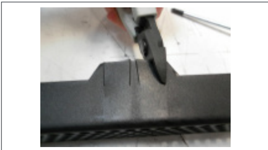
Corte orificios para permitir el acceso de los cables
